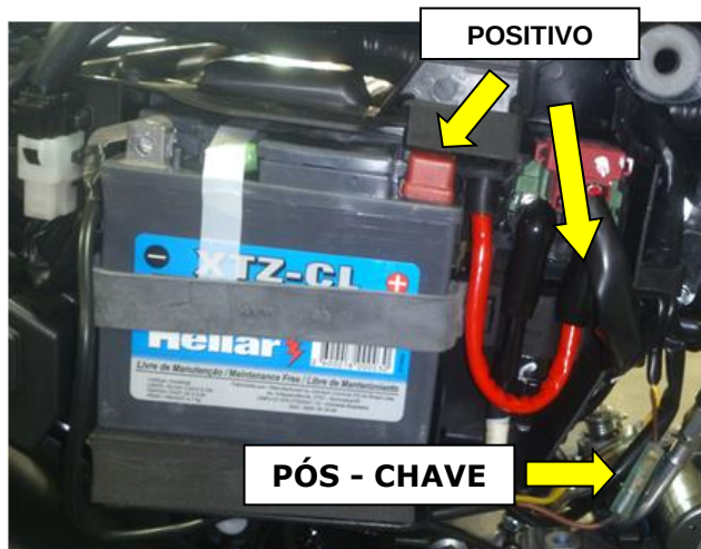
Bateria localizada na lateral
